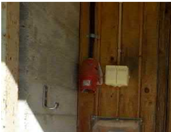
Varavoiman kytkentäpiste sisäänkäynnin luona
