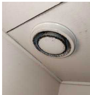
Likaantunut poistoilmaventtiili
