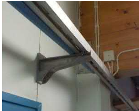
Ripustuskiskoa kalustohallissa
