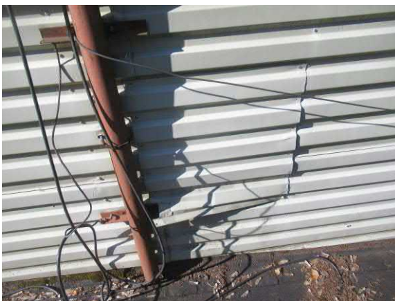
Korkeamman osan yläpohjan profiilipellityksissä paikoin vaurioita ja epätiivelyskohtia
