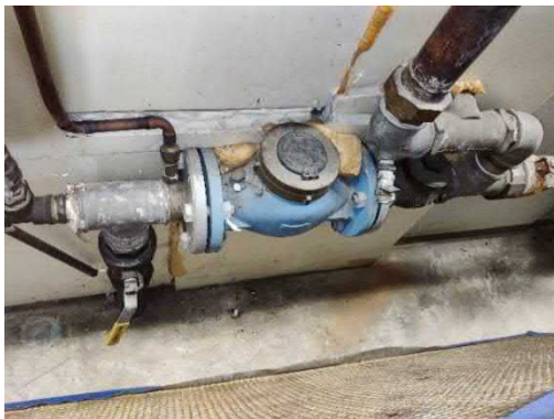
Ikääntynyt päävesimittari
