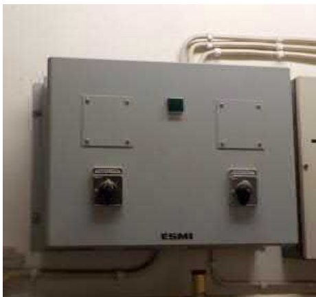
Turvavalokeskus lämmönjakohuoneessa
