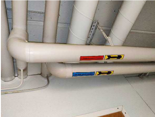
Alkuperäiset käyttövesiputket
