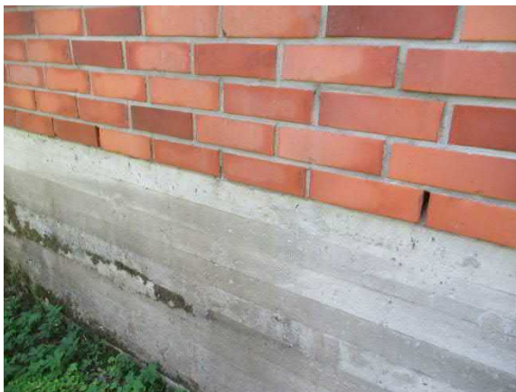
Alimman tiilirivin pystysaumoja jätetty auki ra- kenteen tuulettamiseksi, sokkelissa roiskeveden aiheuttamaa sammalkasvustoa
