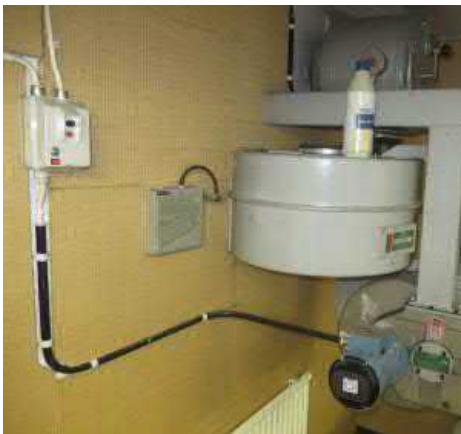
Väestönsuojan IV-koneen sähköistystä
