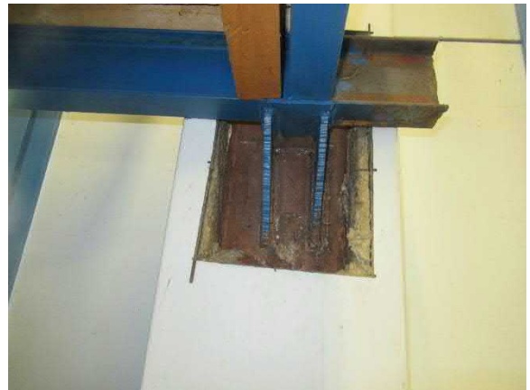
Autohallin pilari, johon kiinnitetty palkkeja
