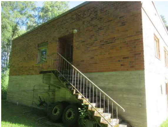
Yleiskuva yläkertaan johtavasta portaikosta, portaikon alla mattoteline
